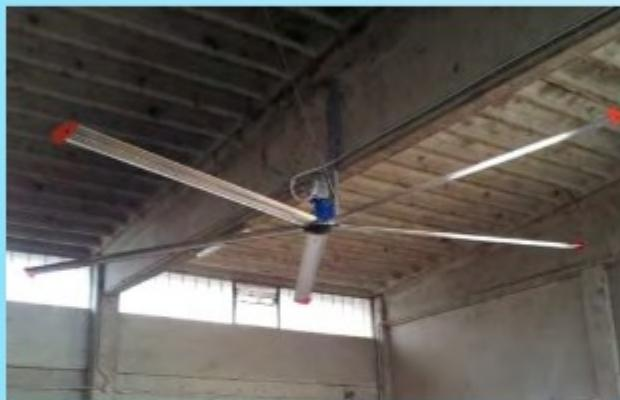
Вентиляторы оснащены пятью лопастями, выполненными из анодированного алюминия, их ширина 22 см. Общий диаметр вентилятора 330 см - 690 см. Лопасти вентилятора на концах имеют специальные крыльышки, которые увеличивают эффективность и устраняют вихри воздушного потока.
