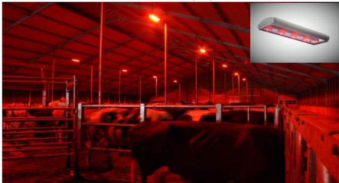
**Энергосберегающие светильники AL2007** предназначены для освещения коровников (для молочного и мясного скота). Варианты комплектации светильников AL2007: натриевые лампы высокого давления HPS или металлогалогенные МН лампы мощностью 250 Вт или 400 Вт. Светильники устойчивы к воздействию влаги, пыли и аммиака.
