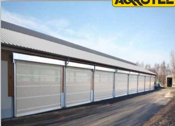
Большие скручивающиеся ворота с ребрами жесткости WST 9 прочные с высокой скоростью открывания и закрывания. Встроенные в тент трубы, являющиеся ребрами жесткости, располагаются на расстоянии 60-70 см друг от друга и плотно встроены в U-шины по бокам.
