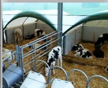
Конструкция групповых домиков состоит из оцинкованной стальной рамы и покрыта специальным мембранным тентом, стойким к УФ-лучам, трудновоспламеняющимся. Три стенки группового домика облицованы высококачественными панелями высотой 1,2 м. Крышу очень легко чистить. В верхней части домика имеется отверстие для проветривания.
